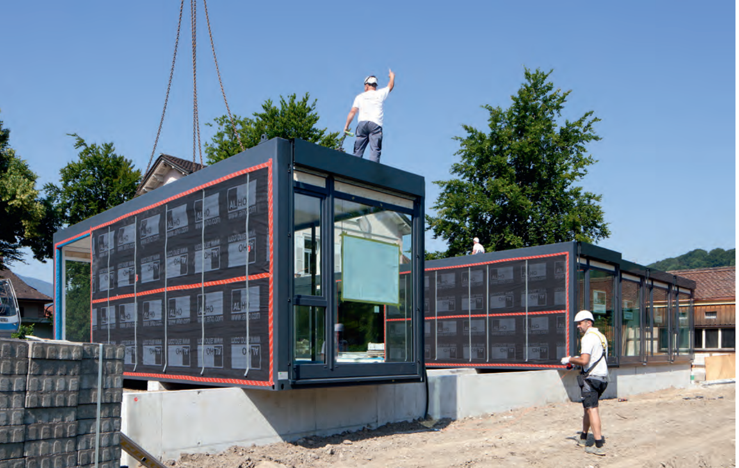
Versetzen der Module
